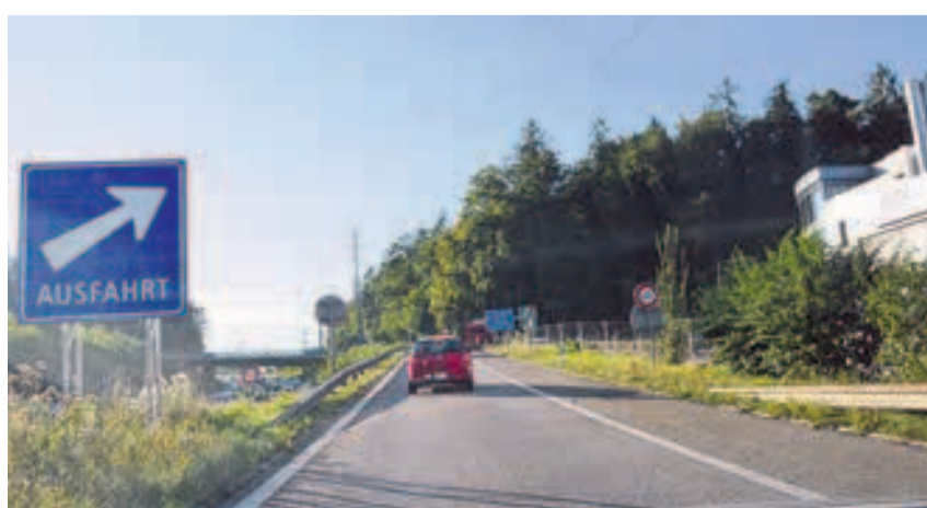
Die Belagsarbeiten betreffen die Ein- und Ausfahrt Schindellegi der Autobahn A3. Bild Archiv
